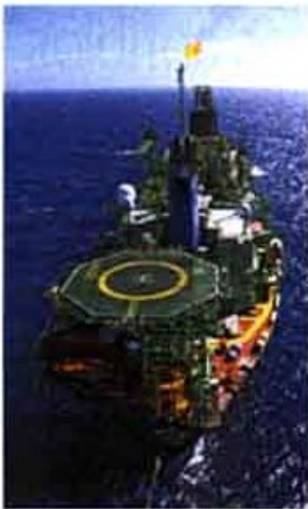
Plataforma marítima da Petrobras
